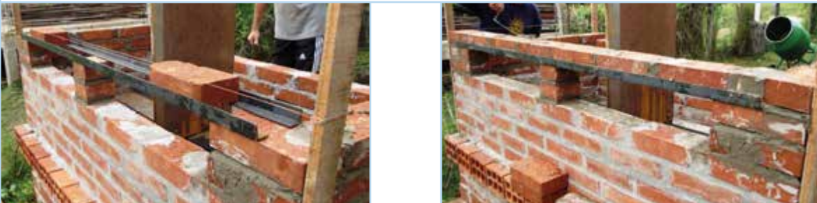
FIGURAS 13 / 14 CONSTRUCCIÓN DE ABERTURAS DONDE SE CONECTARÁ EL COLECTOR SOLAR.
