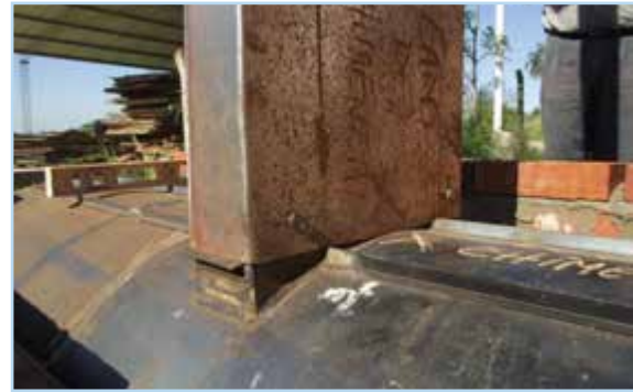
FIGURA 6 UBICACIÓN DE LA CHIMENEA.
