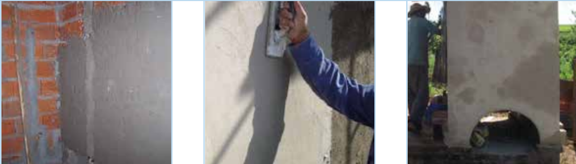
FIGURAS 17 / 18 / 19 REVOQUE DE PAREDES.
