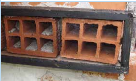
FIGURA 54 TEJIDO DE PROTECCIÓN EN EL INGRESO DE AIRE.
