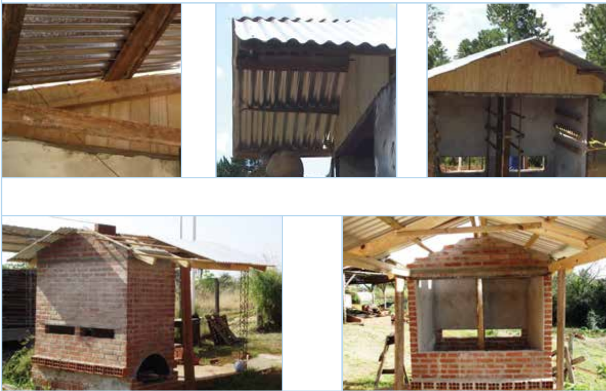
FIGURAS 27 a 31 CONSTRUCCIÓN DEL TECHO DEL SECADERO Y RECINTO DE MANIPULACIÓN.
