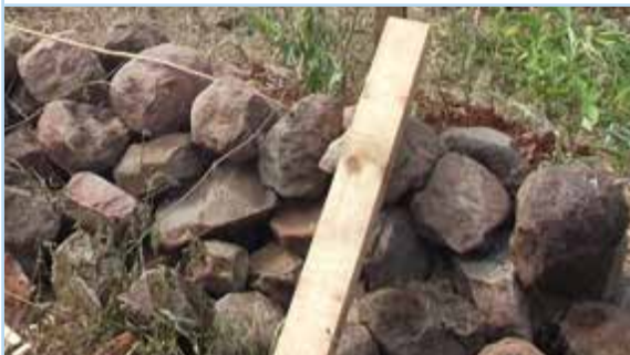
FIGURAS 47 / 48 PIEDRAS PARA ACUMULADOR DE CALOR. PARTE INFERIOR DEL SECADERO.
