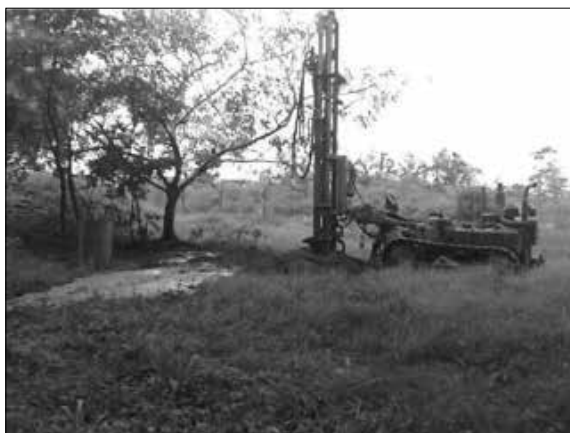
Perforación pozo profundo.
