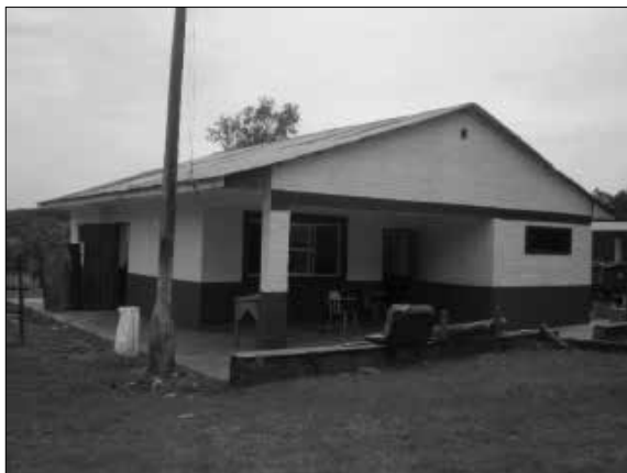
Aula de campo: refacción y terminación.
