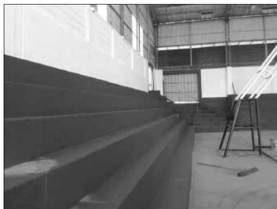
Vista del Polideportivo por dentro (cerramiento completo, sanitarios, depósito de materiales, cantina y pintura). Año 2018.
